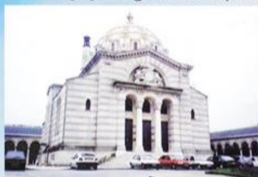
Dom przedpogrzebowy z krematorium.
