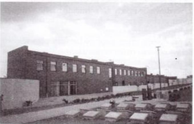
Budynek administracyjno - socjalno - handlowy.
